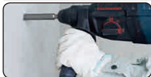
⑤ 打込み(専用マシンホルダー使用)
