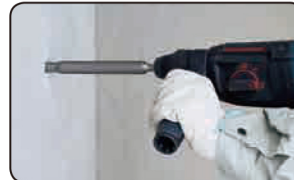
③ 打込み(専用マシンホルダー使用)
